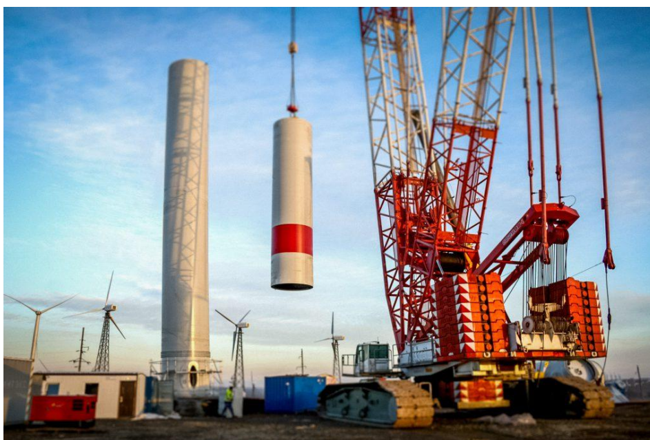
Монтаж вежі ВЕУ
